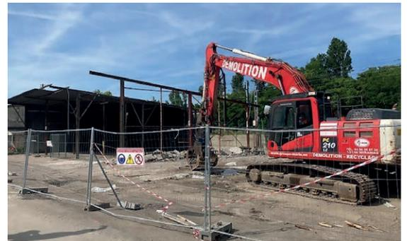
Ces travaux de démolition vont être réalisés par émiettement, ou par fragmentation. Cette technique entame la destruction des infrastructures par le haut, afin de **limiter la production de poussières** : les bâtiments sont d'abord écrêtés puis détruits, étage par étage. La partie inférieure est ensuite détruite de façon mécanique, une fois les étages supérieurs supprimés.
