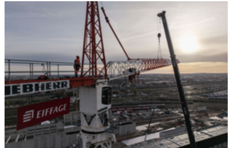
DÉMONTAGE DE LA GRUE G2
