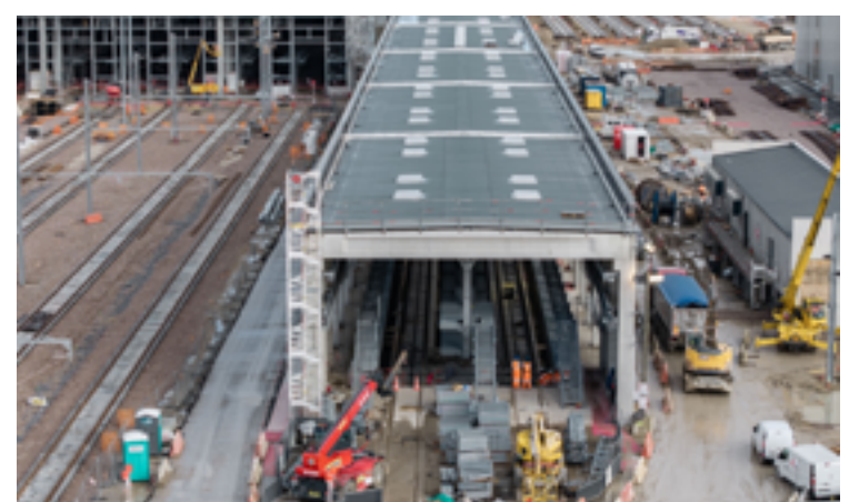
FOCUS SUR L'ATELIER 2 VOIES FOSSE PASSERELLE
