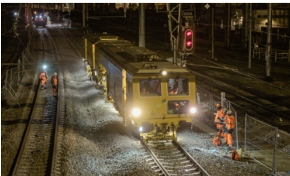
DERNIERS TRAVAUX DE BOURRAGE DE VOIES SUR LE SAS NORD (SITUÉ AUX ABORDS DE LA GARE DE CRETEIL POMPADOUR)
